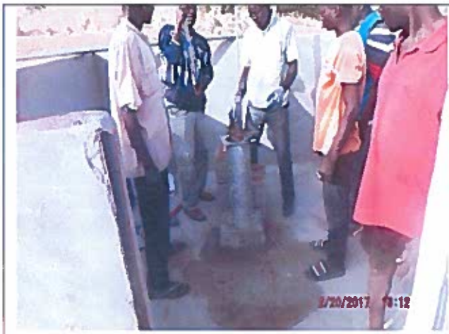
Installation de la pompe INDIA MARK sur le forage
