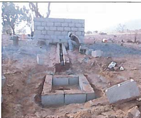
Muret de protection en cours de construction
