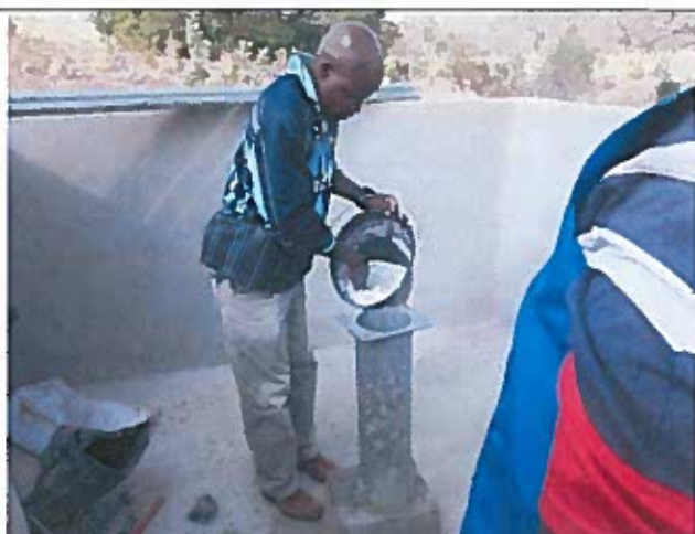
Injection du clore dans le forage
