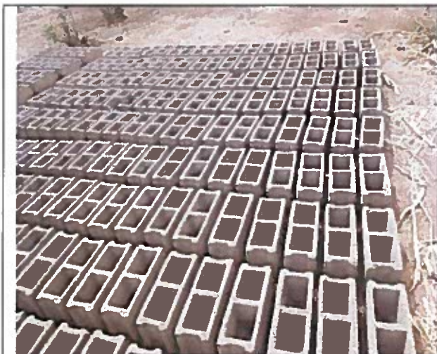
Parpaings pour le muret de protection
