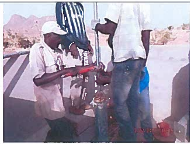
Installation de la pompe INDIA MARK sur le forage
