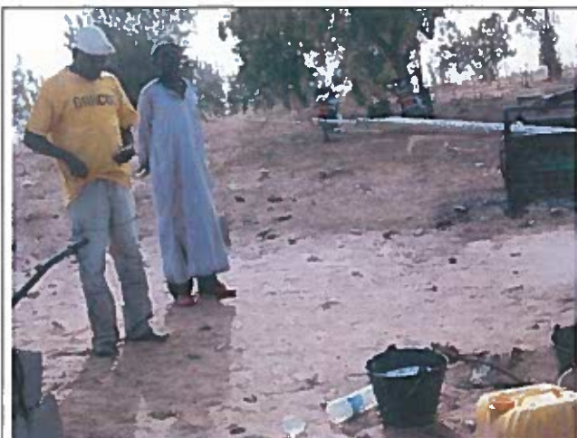
Clore trempé en attente d'injection dans le forage
