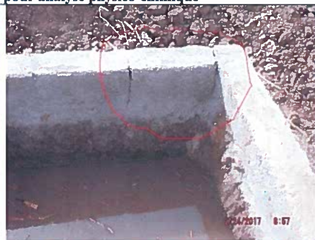
Etat délabré du puits perdu de Bafé lors de prise d'échantillon d'eau pour analyse physico-chimique En date du 24/02/17 c'est-à-dire 10 jours après construction
