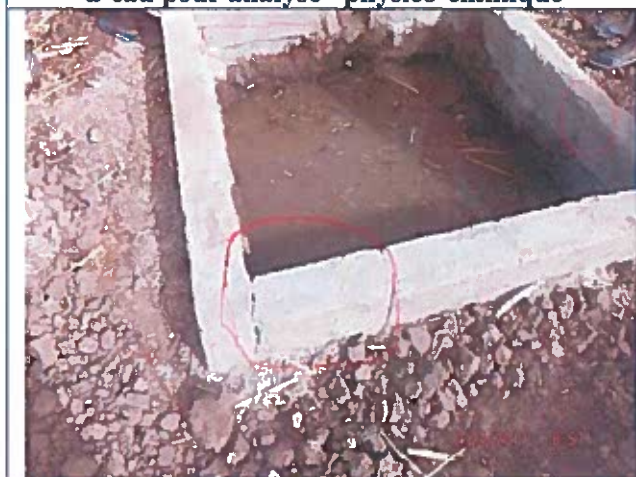
Etat délabré du puits perdu de Bafé lors de prise d'échantillon d'eau pour analyse physico-chimique En date du 24/02/17 c'est-à-dire 10 jours après construction
