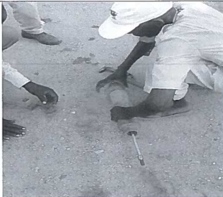
Intervention au niveau des éléments immergés (cylindre corps de pompe)
